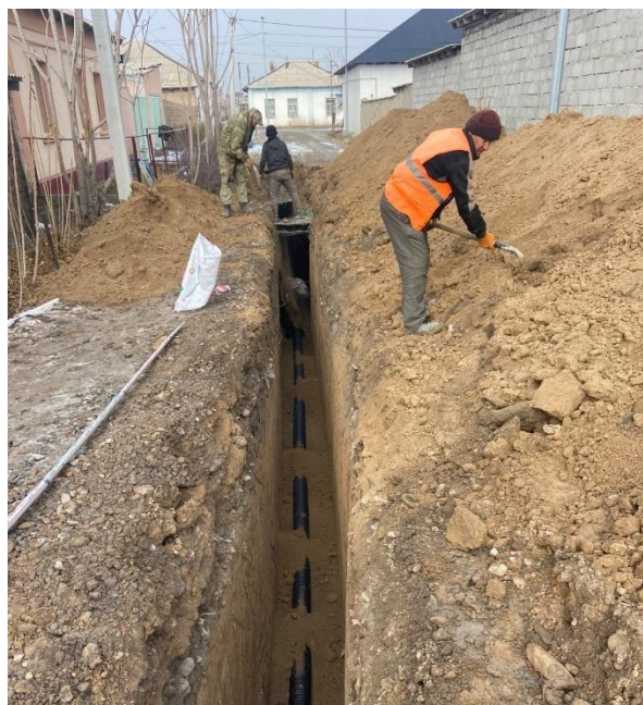
2.5-сурет – Диаметрі 160 мм гофрленген құбырлардың салыну процесі
