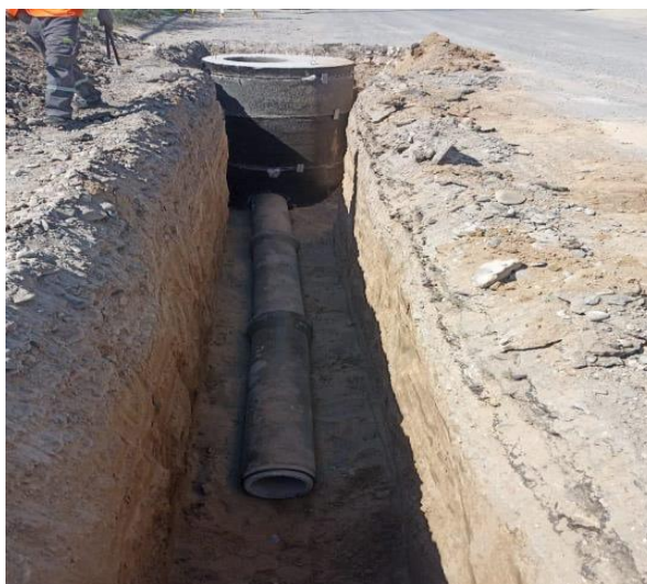
2.4-сурет – Диаметрі 400 мм темірбетон құбырының салыну процесі
