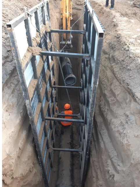
1.4-сурет – Кәріз желілерін салу процесі
